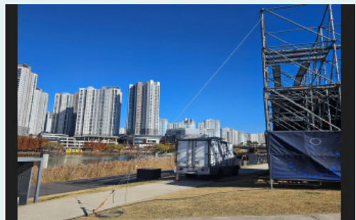
〈 전도방지용 와이어 설치 〉
