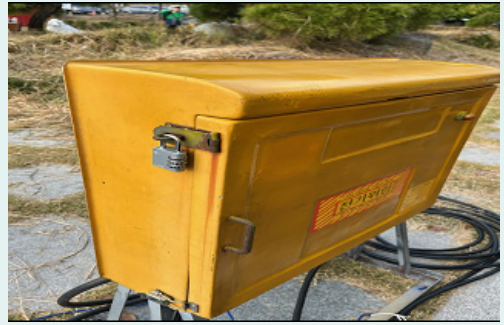
〈분전함 시건장치 설치〉
