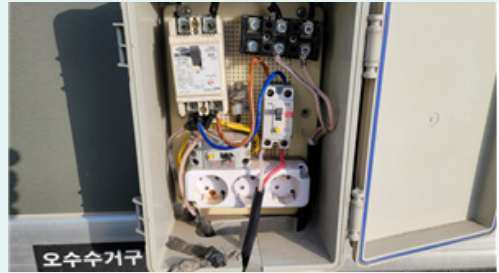
〈누전 차단기 설치〉
