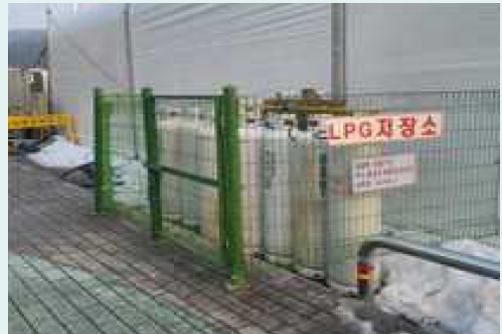
〈안전렌스 설치, 출입금지 표시 부착〉
