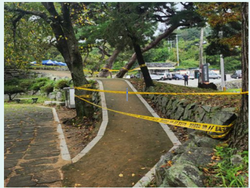
〈미끄러운 경사지 출입통제 안전선 설치〉
