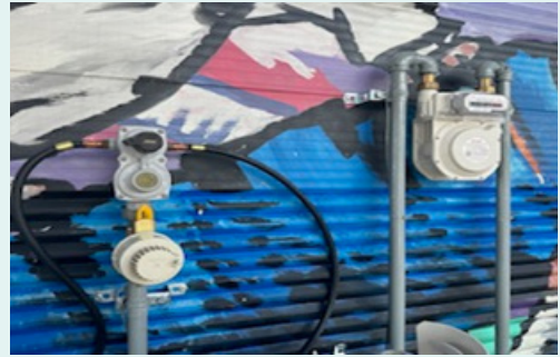
〈가스 차단기 및 누출 경보기 설치〉
