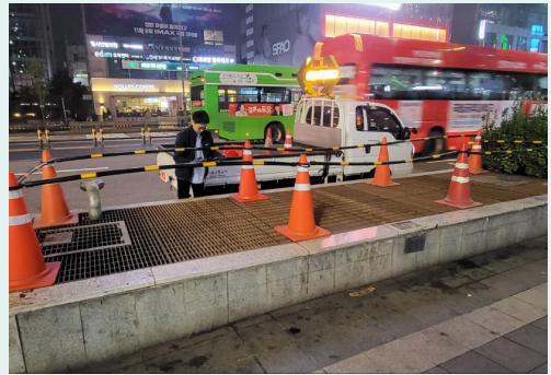
〈환풍구 접근제한 라바콘 설치〉
