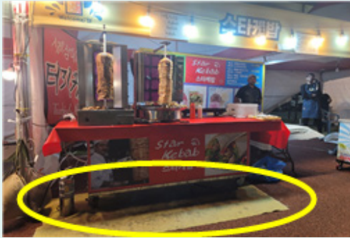
〈조리 부스 방염매트 설치 완료〉
