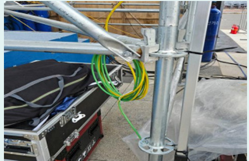
〈무대 철제 비계 접지 시공〉
