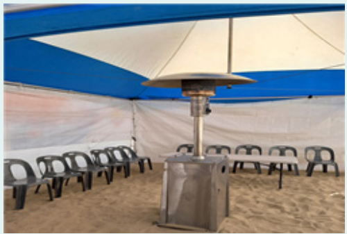
〈 가스난로 연통이 천장과 가까웠음 → 연통 높이를 낮춰 이격거리 확보 〉
