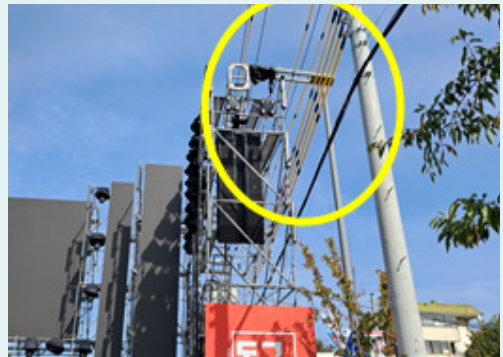
〈전선 보호관 설치〉
