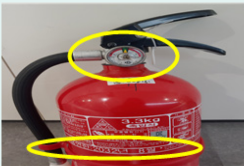
〈소화기 압력불량 및 내구연한, 안전핀·호스·노즐 표면 관리상태 확인〉
