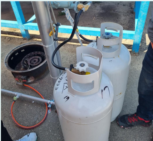
〈가스용기 미고정 및 차방방지캡 미설치〉
