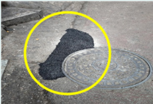
〈 맨홀 뚜껑 옆 땅꺼짐 보수 조치 〉
