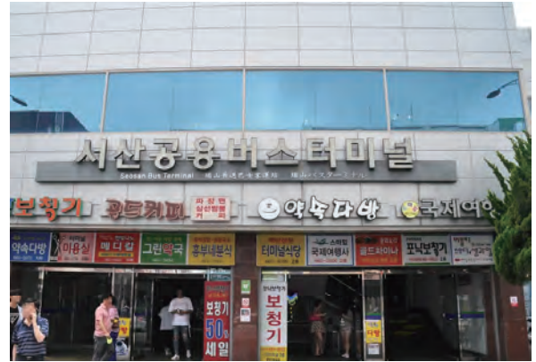
서산공용버스터미널 건물 외관(출처: 나무위키)
