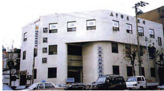
개관 당시 현대갤러리가 있던 이미동 산부인과 건물(출처: 『향토문화자료(7) 중구문화길라잡이』, 대전중구문화원, 1998, p. 16.)
