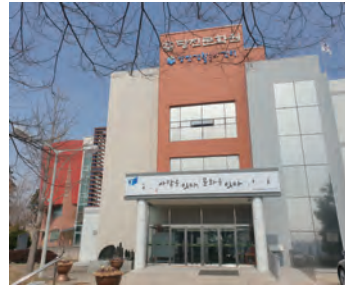
2층 전시장을 갖춘 당진생활문화센터의 전경(출처: https://m.blog.naver.com/dangjin2030/ )
