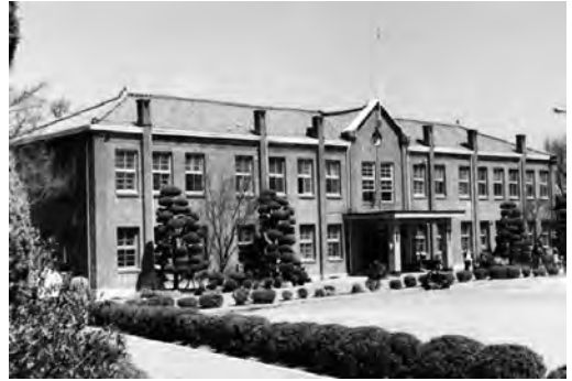
중구 목동에 세워진 당시의 목원대학교(감리교대전신학원) 캠퍼스 전경.
