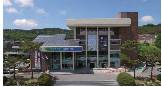
서산문화회관 전경(출처: 네이버지식백과)
